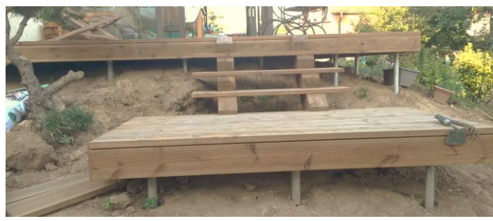
Utilisation de pieux
