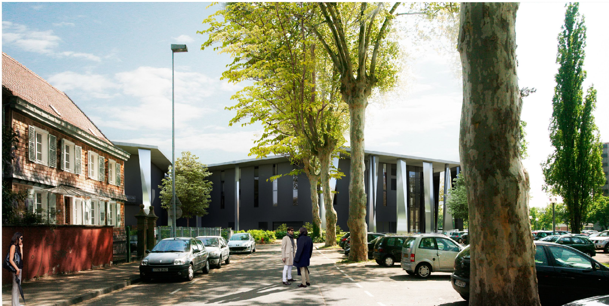
vue sur PMC 3 depuis rue du Tivoli
