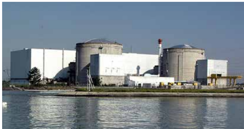
La centrale de Fessenheim
