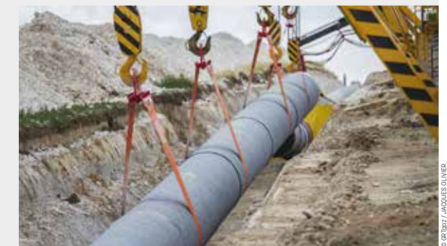
Travaux de construction du gazoduc Arc de Dierrey.
