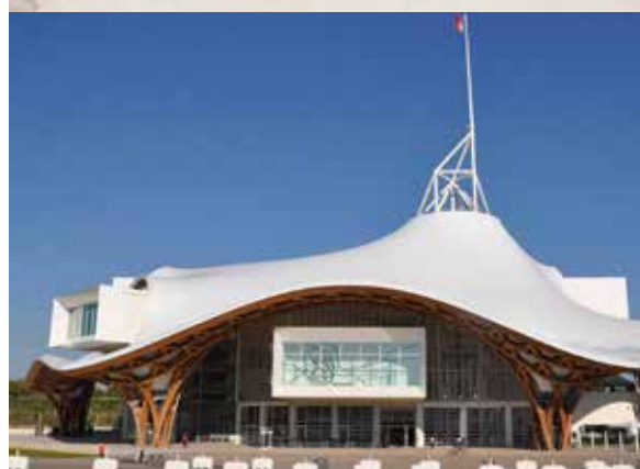
Le Centre Pompidou à Metz.
