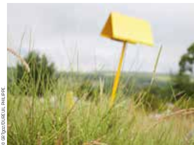
Balise alertant de la présence d'un gazoduc.
